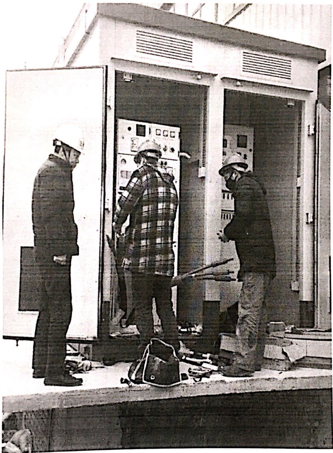
箱变电缆头制作监理旁站
