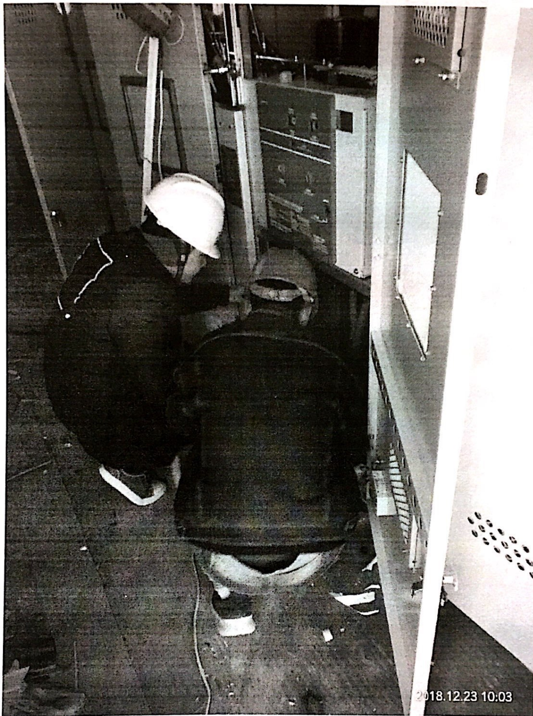
箱变电缆头制作监理旁站
