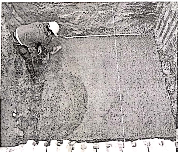
旁站浇筑光伏 车棚基础垫层
