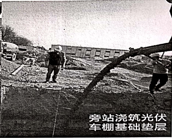
光伏车棚基础垫层 浇筑完成
