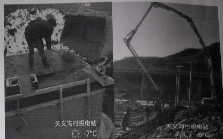
一二次舱、svg、箱变基础浇筑混凝土
