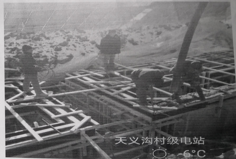
一二次舱基础浇筑混凝土
