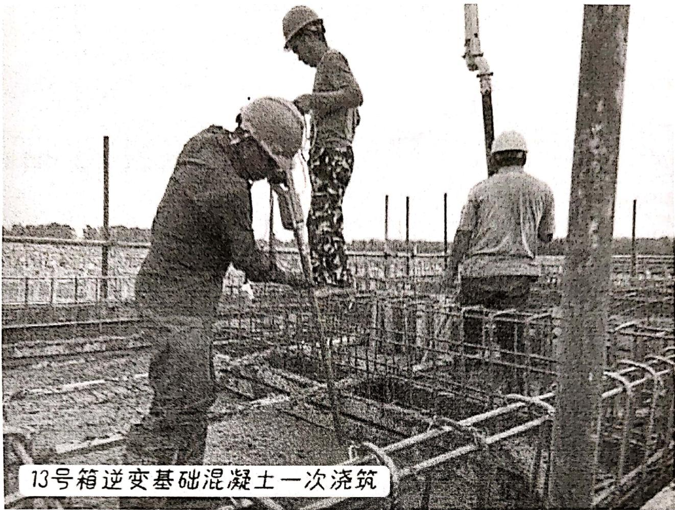
13号箱逆变基础混凝土一次浇筑
