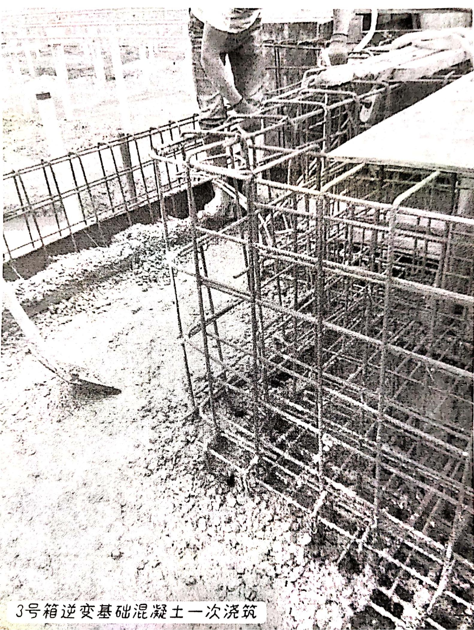
3号箱逆变基础混凝土一次浇筑
