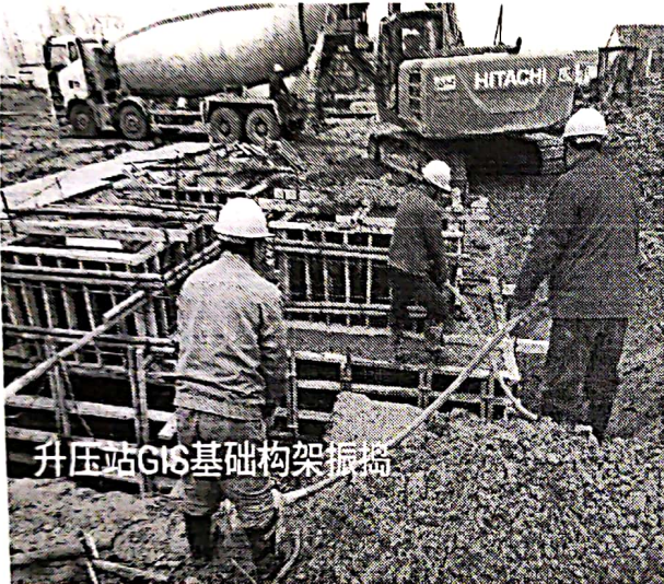
升压站GIS基础构架浇筑
