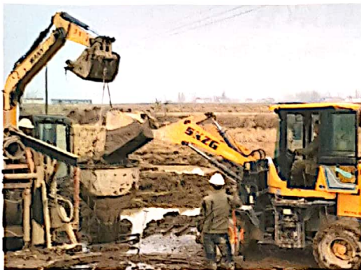
混凝土浇筑
