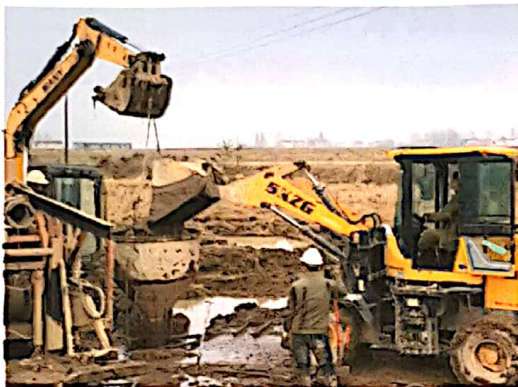
混凝土浇筑
