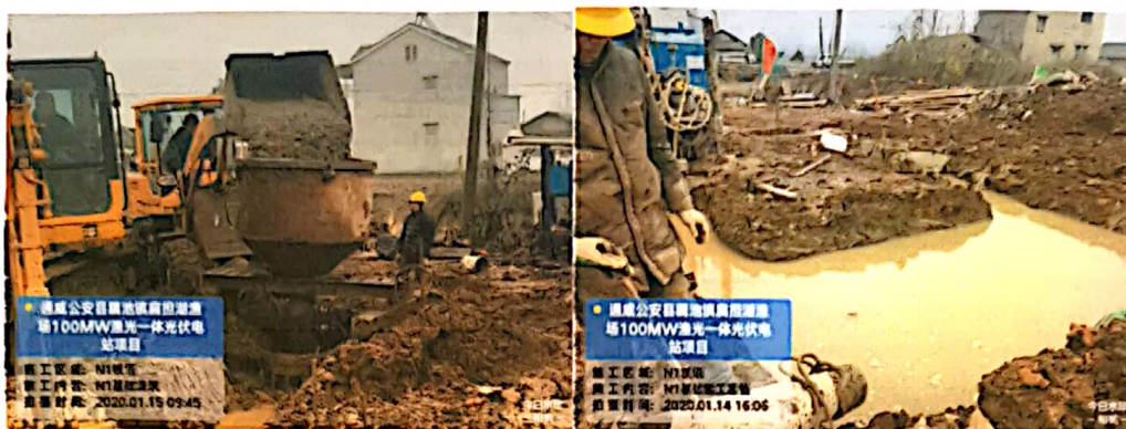
混凝土浇筑
