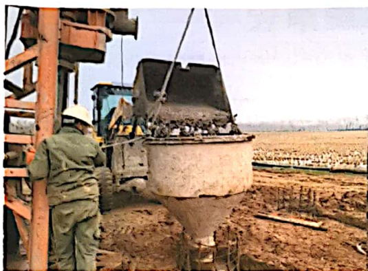
混凝土浇筑
