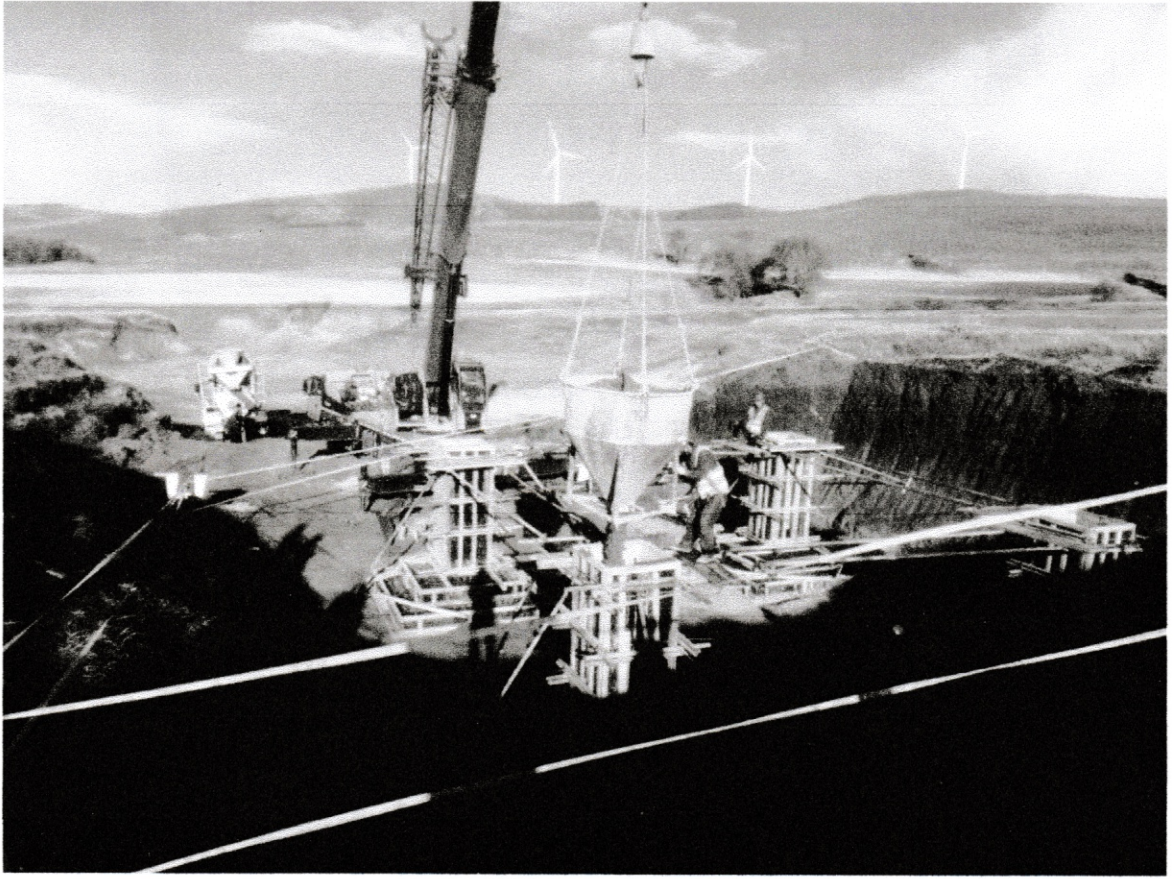
AN31#铁塔检测混凝土浇筑
