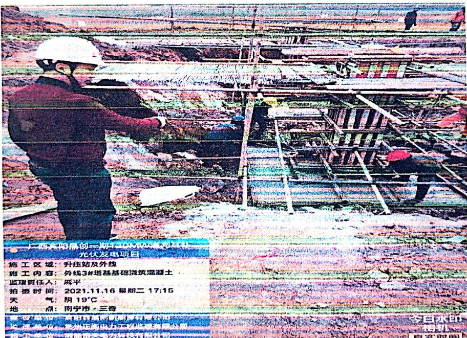
监理人员已经检查了钢筋绑扎及模板安装情况，检查了商砼出厂证明、合格证情况，均符合设计及规范要求。A、B、C、D 四个腿一次性浇筑完成。要求现场制作试块，标准养护试块作为验证配合比依据。混凝土振捣时，做到快插慢拔，振动器插点均匀，连续振捣时间约为 25S-40S，以混凝土表面出现浮浆为止，没有漏浆、跑浆现象。已要求施工方浇筑完成后对混凝土进行养护。
