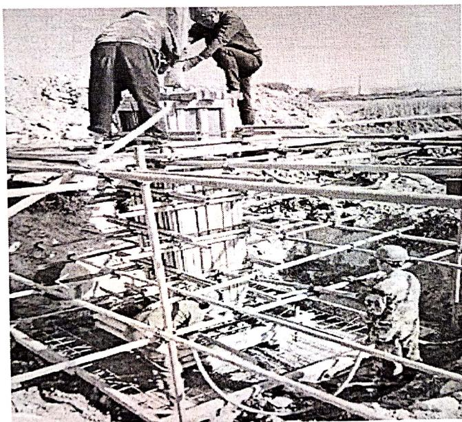
监理人员已经检查了钢筋绑扎及模板安装情况，检查了商砼出厂证明、合格证情况，均符合设计及规范要求。A、B、C、D 四个腿一次性浇筑完成。要求现场制作试块，标准养护试块作为验证配合比依据。混凝土振捣时，做到快插慢拔，振动器插点均匀，连续振捣时间为 25S-40S，以混凝土表面出现浮浆为止，没有漏浆、跑浆现象。已要求施工方浇筑完成后对混凝土进行养护。
