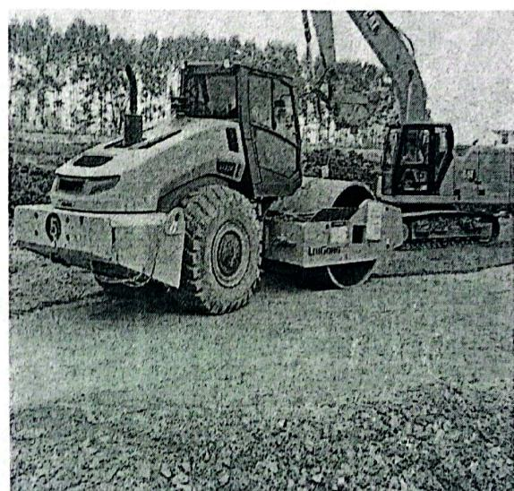
监理人员已经检查地基内无积水、杂物，回填过程中一直在现场旁站监督管理，地基回填已要求施工单位按照设计及规范要求进行分层压实，已检查回填毛石、砂砾石符合设计要求。已要求施工单位做好压实系数试验及地基承载力试验。
