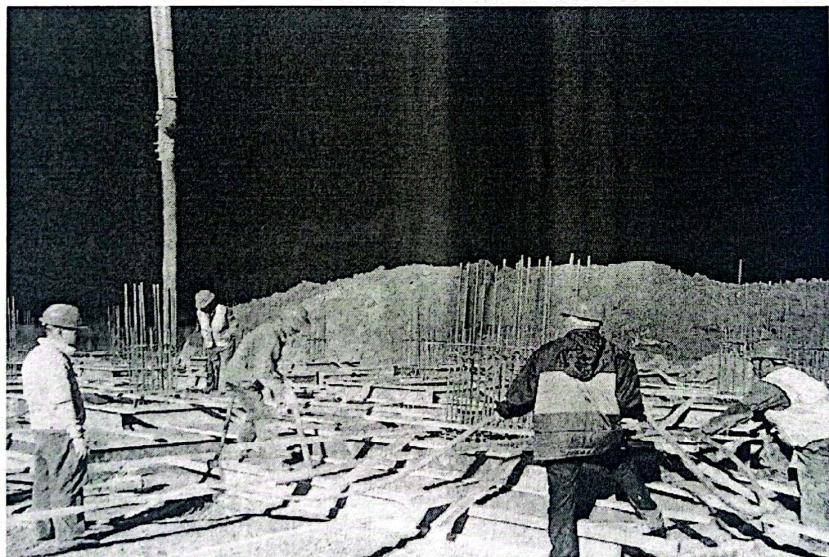
监理人员已经检查了钢筋绑扎及模板安装情况，检查了商砼出厂证明、合格证情况，模板尺寸偏差均符合设计及规范要求。已要求现场制作试块，标准养护、同条件试块作为验证配合比依据。混凝土振捣时，做到快插慢拔，振动器插点均匀，连续振捣时间约为 25S-40S，以混凝土表面出现浮浆为止，没有漏浆、跑浆现象。已要求施工方浇筑完成后对混凝土进行养护。
