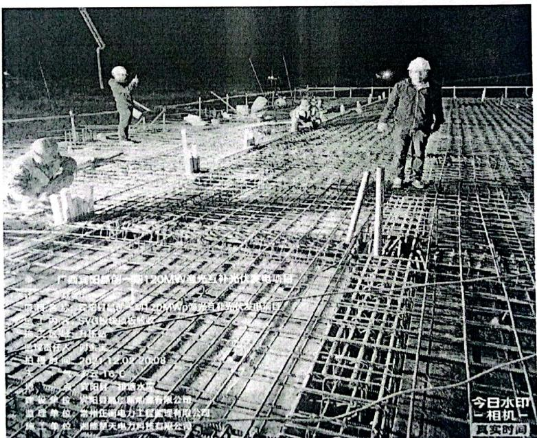
监理人员已经检查了钢筋绑扎及模板安装情况，检查了商砼出厂证明、合格证情况，均符合设计及规范要求。已要求现场制作试块，标准养护、同条件试块作为验证配合比依据。混凝土振捣时，做到快插慢拔，振动器插点均匀，连续振捣时间约为 25S-40S，以混凝土表面出现浮浆为止，没有漏浆、跑浆现象。已要求施工方浇筑完成后对混凝土进行养护。
