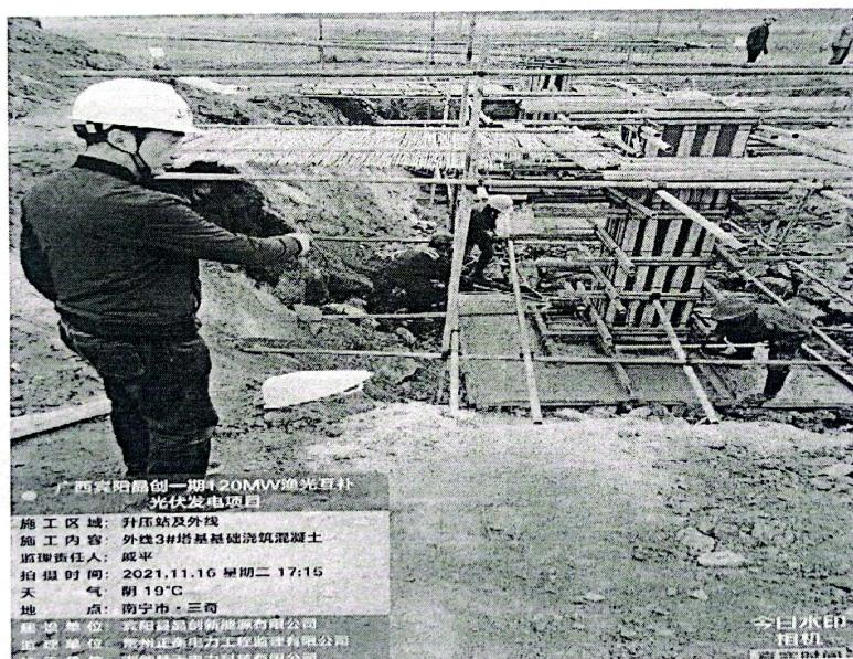
监理人员已经检查了钢筋绑扎及模板安装情况，检查了商砼出厂证明、合格证情况，均符合设计及规范要求，对塌落度进行了抽检，实测为 179mm，符合要求。A、B、C、D 四个腿一次性浇筑完成。要求现场制作试块，标准养护试块作为验证配合比依据。混凝土振捣时，做到快插慢拔，振动器插点均匀，连续振捣时间约为 25S-40S，以混凝土表面出现浮浆为止，没有漏浆、跑浆现象。已要求施工方浇筑完成后对混凝土进行养护。
