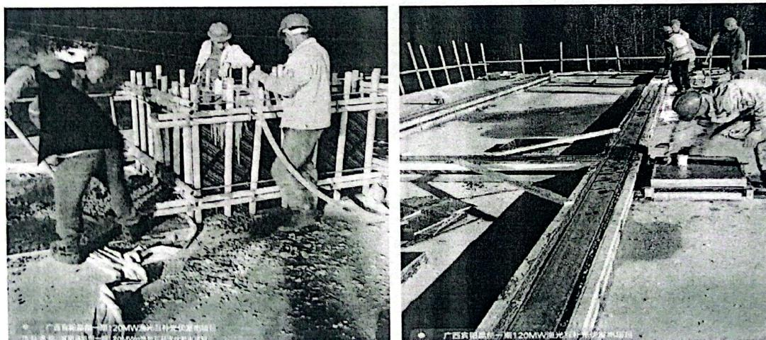
监理人员已经检查了钢筋绑扎及模板安装情况，检查了商砼出厂证明、合格证情况，均符合设计及规范要求。已要求现场制作试块，标准养护、同条件试块作为验证配合比依据。混凝土振捣时，做到快插慢拔，振动器插点均匀，连续振捣时间约为 25S-40S，以混凝土表面出现浮浆为止，没有漏浆、跑浆现象。已要求施工方浇筑完成后对混凝土进行养护。
