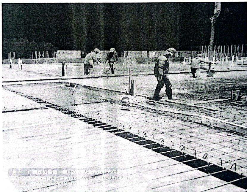
监理人员已经检查了钢筋绑扎及模板安装情况，检查了商砼出厂证明、合格证情况，均符合设计及规范要求。已要求现场制作试块，标准养护、同条件试块作为验证配合比依据。混凝土振捣时，做到快插慢拔，振动器插点均匀，连续振捣时间约为 25S-40S，以混凝土表面出现浮浆为止，没有漏浆、跑浆现象。已要求施工方浇筑完成后对混凝土进行养护。
