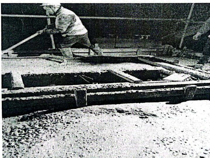
监理人员已经检查了钢筋绑扎及模板安装情况，符合图纸设计及规范要求；检查了商砼出厂证明、合格证情况，模板尺寸偏差均符合设计及规范要求。已要求现场制作试块，标准养护、同条件试块作为验证配合比依据。混凝土振捣时，做到快插慢拔，振动器插点均匀，连续振捣时间为 25S-40S，以混凝土表面出现浮浆为止，没有漏浆、跑浆现象。已要求施工方浇筑完成后对混凝土进行养护。
