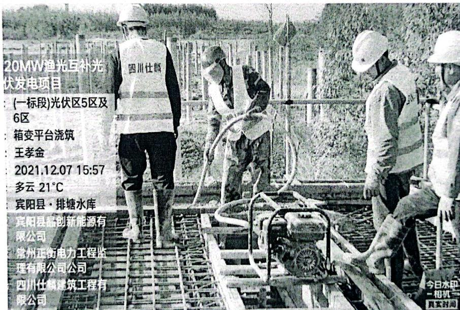
监理人员已经检查了钢筋绑扎及模板安装情况，符合图纸设计及规范要求；检查了商砼出厂证明、合格证情况，模板尺寸偏差均符合设计及规范要求。已要求现场制作试块，标准养护、同条件试块作为验证配合比依据。混凝土振捣时，做到快插慢拔，振动器插点均匀，连续振捣时间为 25S-40S，以混凝土表面出现浮浆为止，没有漏浆、跑浆现象。已要求施工方浇筑完成后对混凝土进行养护。
