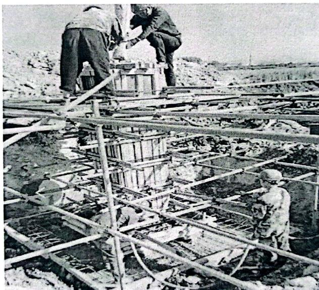
监理人员已经检查了钢筋绑扎及模板安装情况，检查了商砼出厂证明、合格证情况，均符合设计及规范要求，对塌落度进行了抽检，实测为 179mm，符合要求。A、B、C、D 四个腿一次性浇筑完成。要求现场制作试块，标准养护试块作为验证配合比依据。混凝土振捣时，做到快插慢拔，振动器插点均匀，连续振捣时间约为 25S-40S，以混凝土表面出现浮浆为止，没有漏浆、跑浆现象。已要求施工方浇筑完成后对混凝土进行养护。
