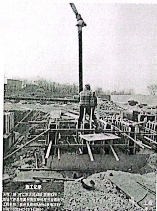
GIS 基础混凝土浇筑
