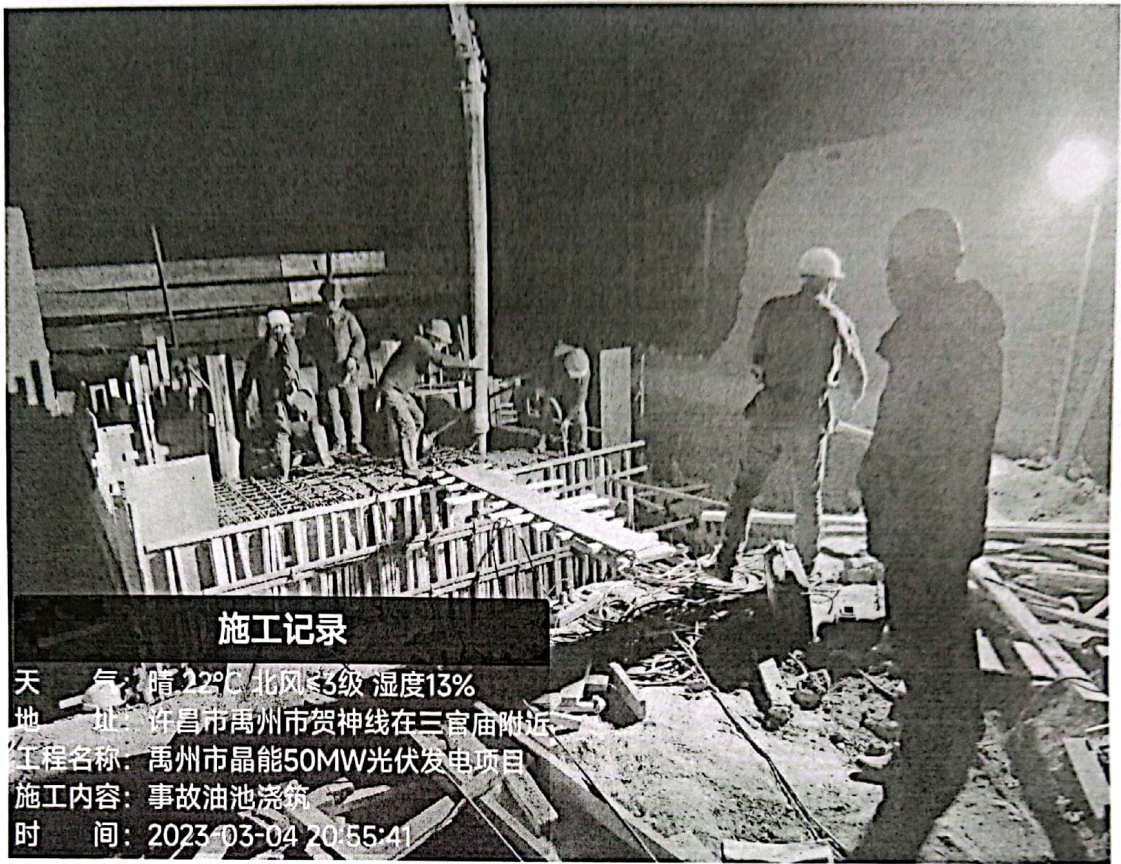
浇筑监理旁站
