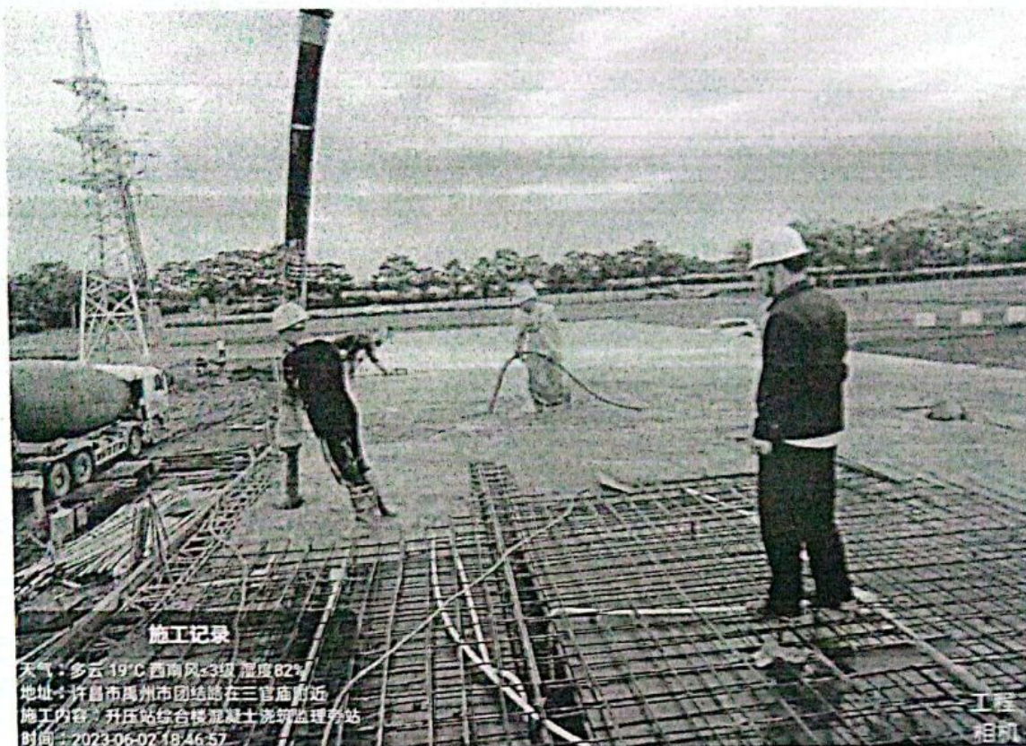
综合楼梁板混凝土浇筑
