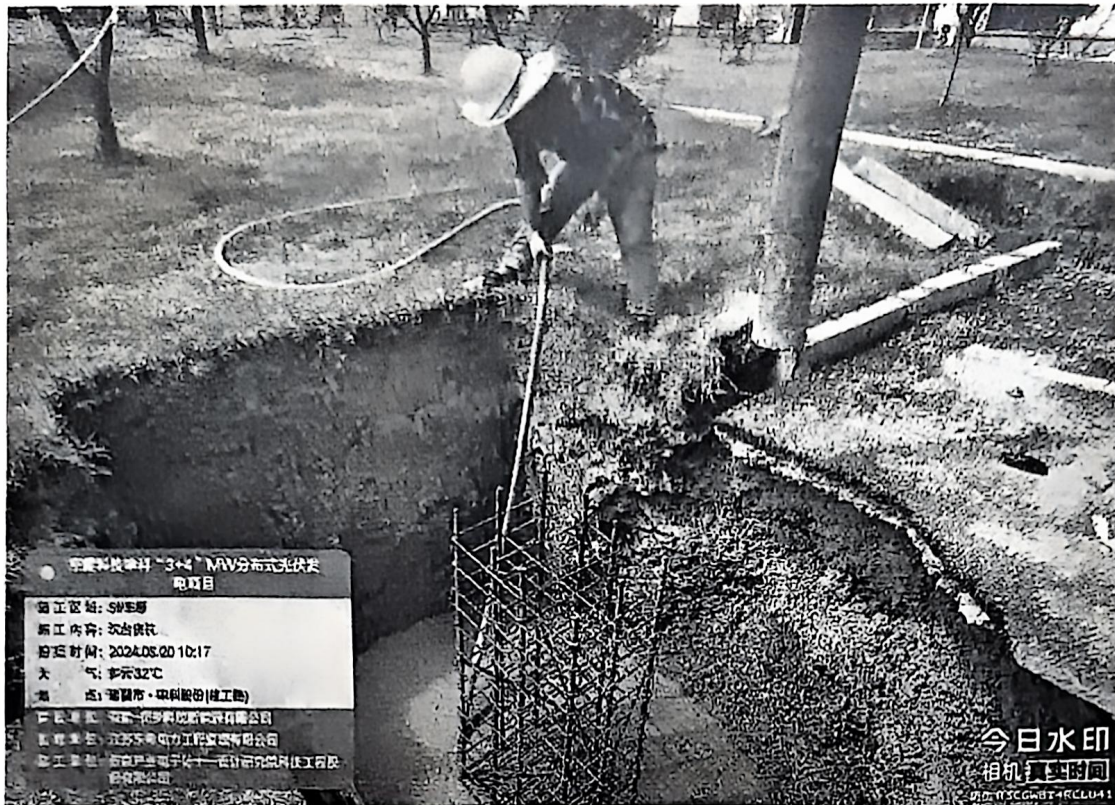
旁站监理记录表 JNTX-JSDD-PZ-010(附图)
