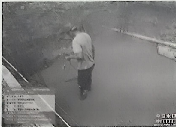
旁站监理记录表 JNTX-JSDD-PZ-016(附图)
