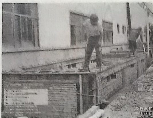
旁站监理记录表 JNTX-JSDD-PZ-019(附图)
