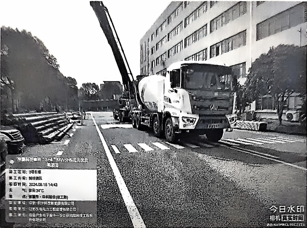
旁站监理记录表 JNTX-JSDD-PZ-009(附图)
