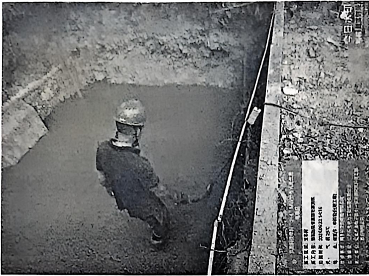
旁站监理记录表 JNTX-JSDD-PZ-014(附图)
