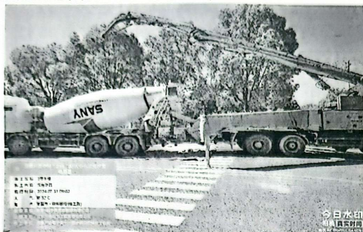
旁站监理记录表 JNTX-JSDD-PZ-007(附图)
