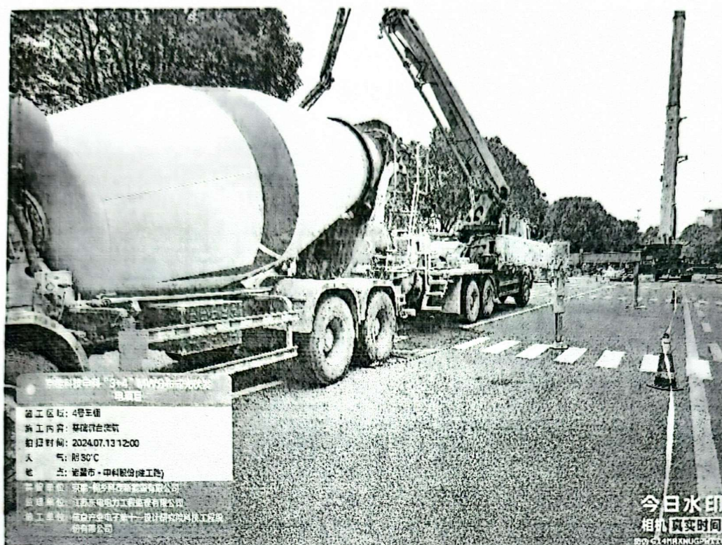
旁站监理记录表 JNTX-JSDD-PZ-002(附图)
