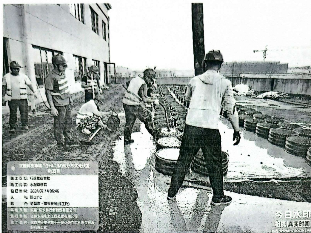
旁站监理记录表 JNTX-JSDD-PZ-003(附图)
