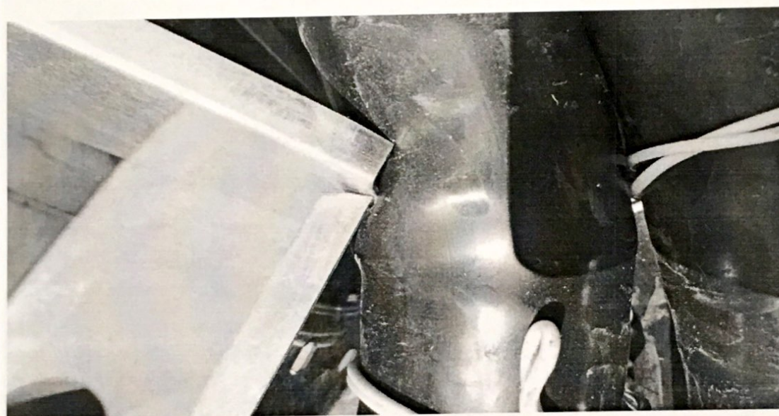
四、房顶通风顶的逆变器走线管没有做防水处理
