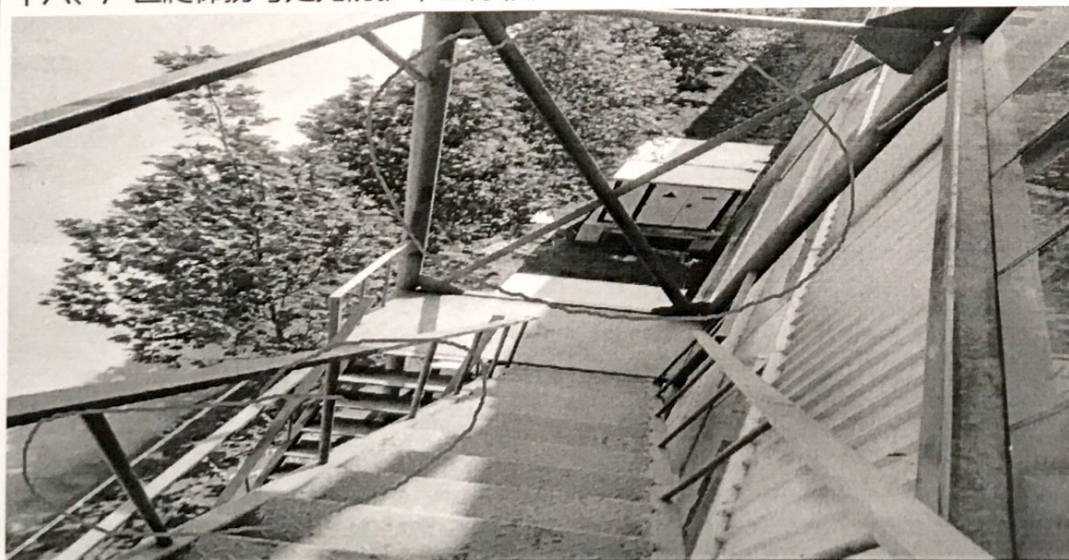
十六、厂区爬梯拐弯处无防护，空隙很大
