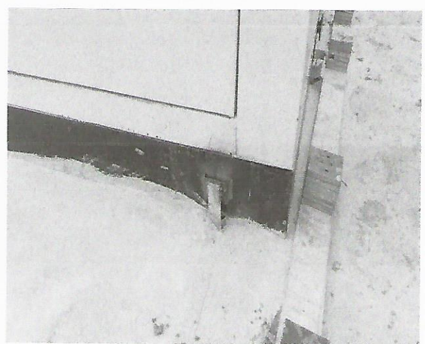
24、预制仓二次接地未和主接地网连接，箱体接地不规范未做防腐。
