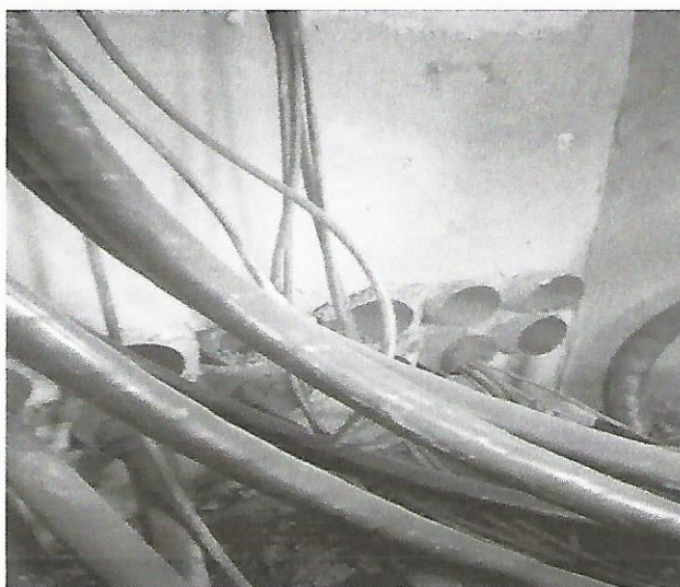
18、1#箱逆变基础下未封堵存在安全质量隐患。
