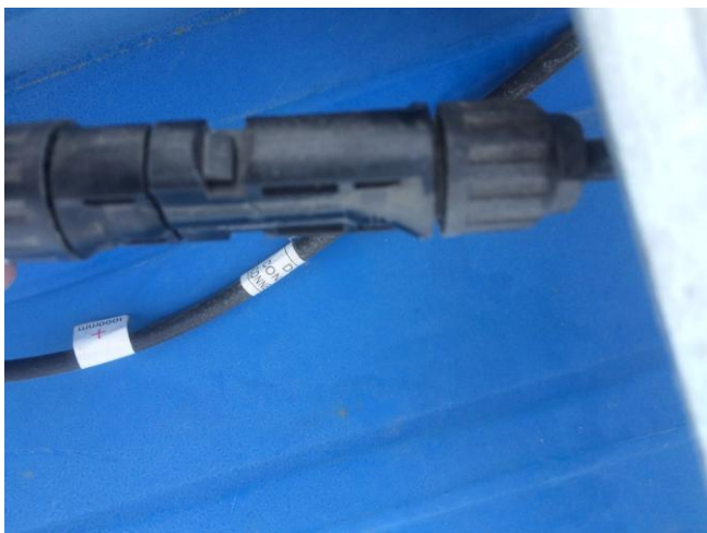
24、屋面电缆桥架盖板个别固定不牢固。
