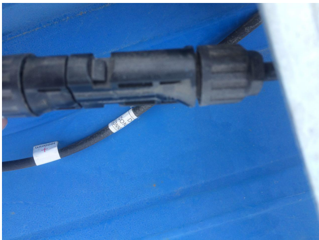
24、屋面电缆桥架盖板个别固定不牢固。
