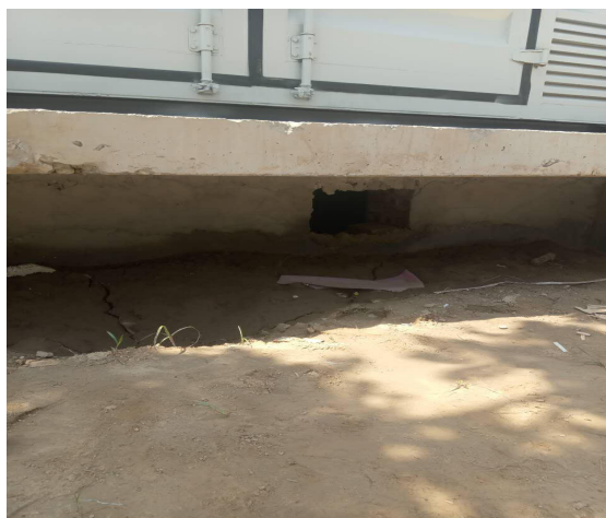
6 百叶窗未安装基础未按层夯实 7 部分台阶下沉 SVG 裸漏电缆未做防火处
