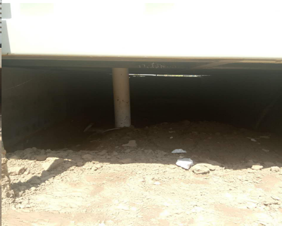
6 百叶窗未安装基础未按层夯实 7 部分台阶下沉 SVG 裸漏电缆未做防火处
