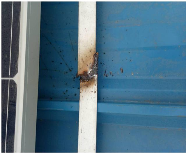
9、接地扁铁焊接面未满足工艺要求三面焊接面积不够
