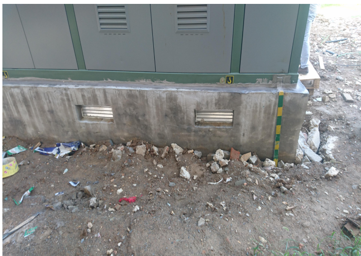
10、箱变基础周边未硬化，未设置围栏
