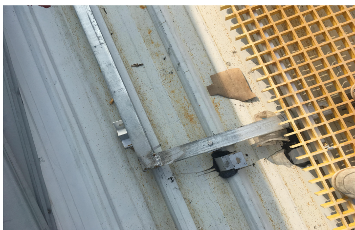
7、接地扁铁焊接处焊接面不足，未三面焊接
