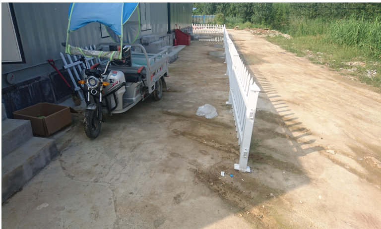
13、开关站周围围栏不符合业主要求且道路未硬化
