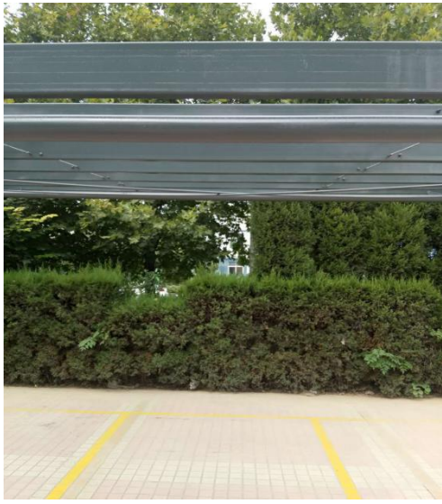
1.车棚部分拉筋松动
