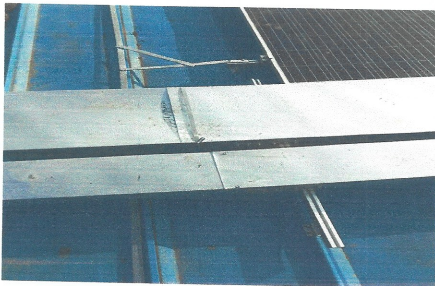
10、一次汇集站屋顶桥架下口电缆沟深度不符规范要求
