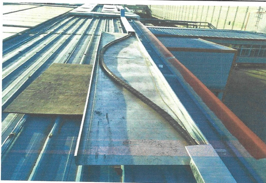
9、桥架盖板封盖紧固用不锈钢扎带进行紧固
