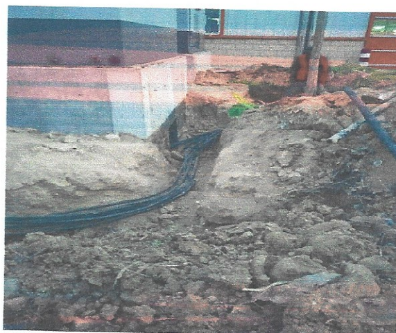
10、一次汇集站屋顶桥架下口电缆沟深度不符规范要求
