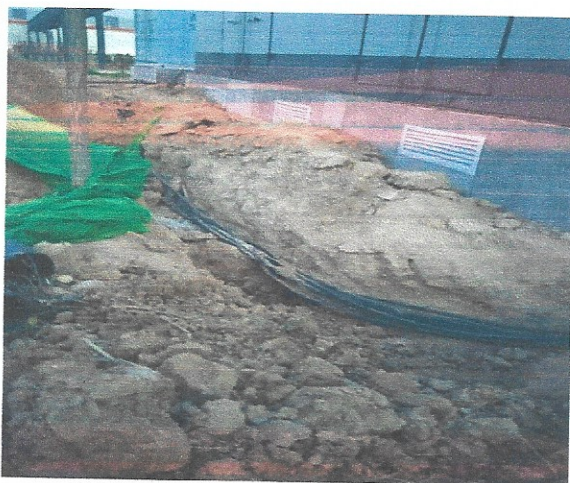
10、一次汇集站屋顶桥架下口电缆沟深度不符规范要求
