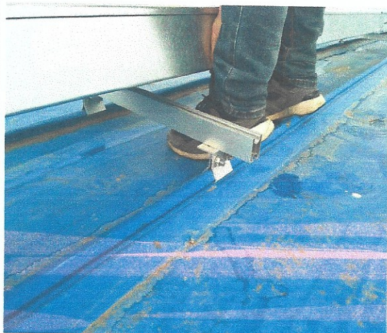
10、在桥架拐弯处未对电缆做有效的保护
