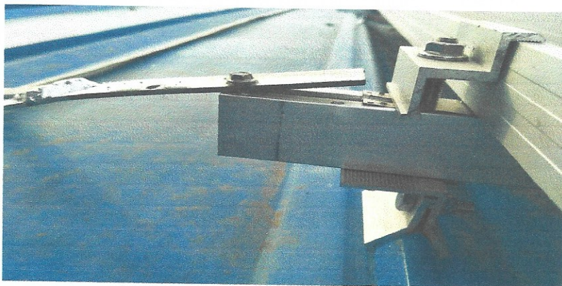
13、电缆未穿管敷设
