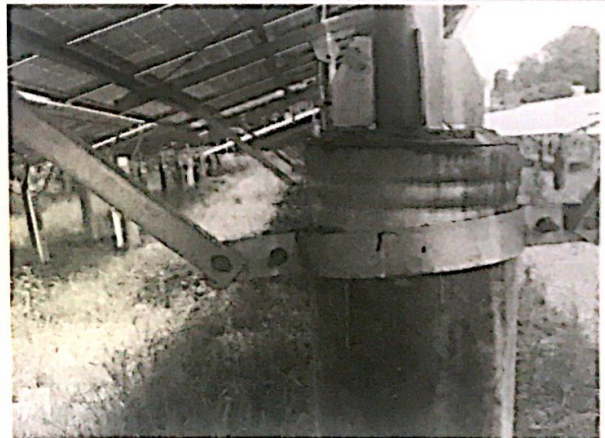
10、橡胶封闭环安装不到位。
