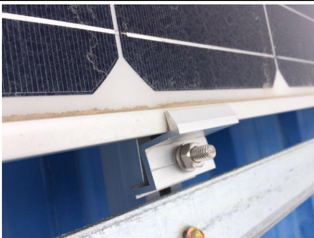
7、屋面个别电缆桥架封盖固定不牢固。
