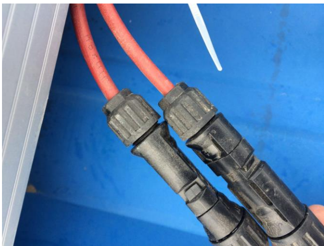
9、屋面组件表面敷设厂房用电线。
