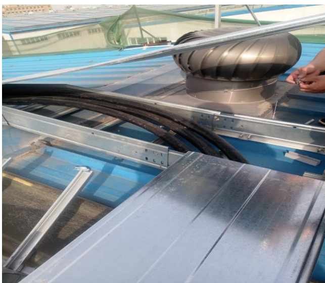
8、屋面个别 MC4 接头接线口未拧紧。
