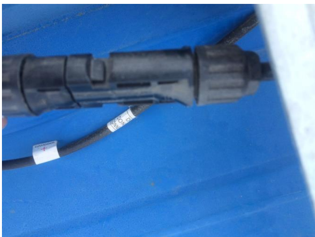
19、屋面电缆桥架盖板个别固定不牢固。
