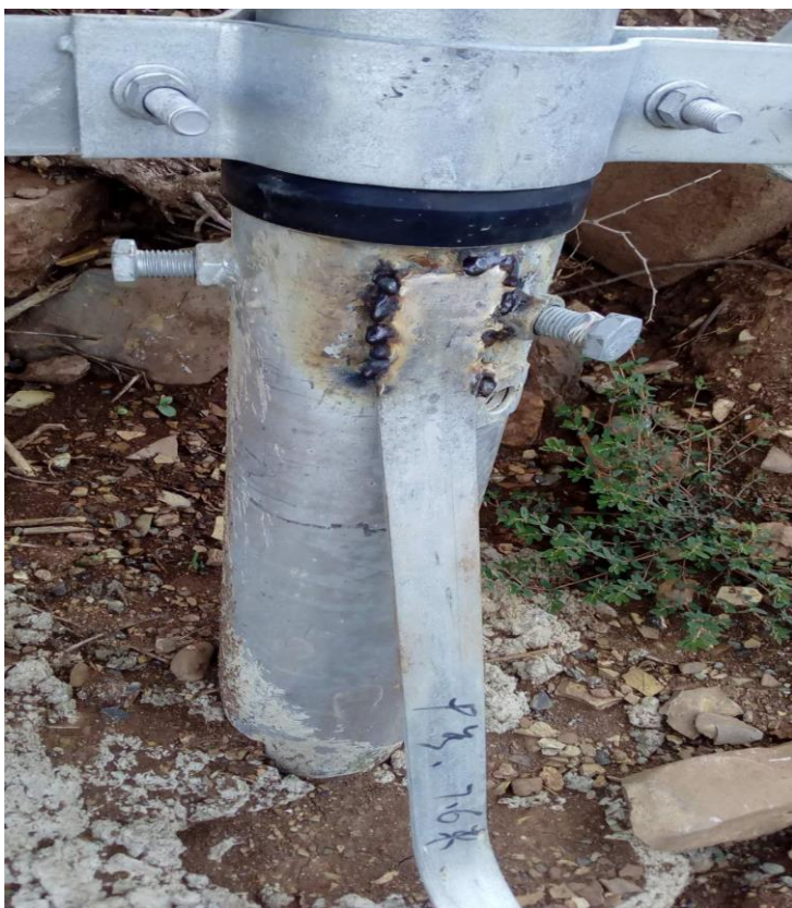
21、地面桥架基础不符合要求。
