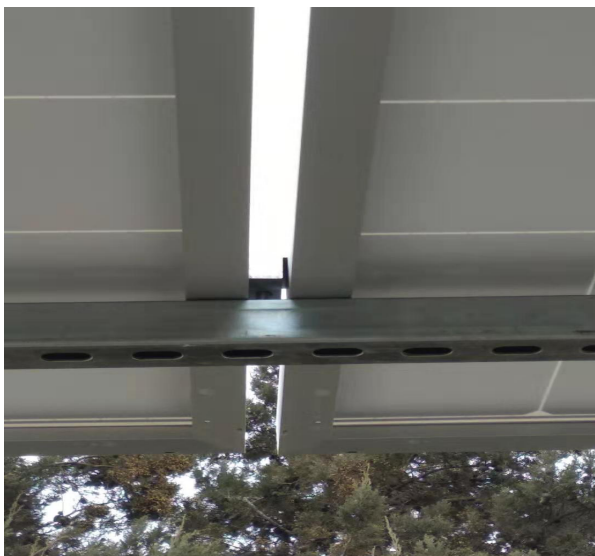
电缆固定不符合规范要求且未作防护
