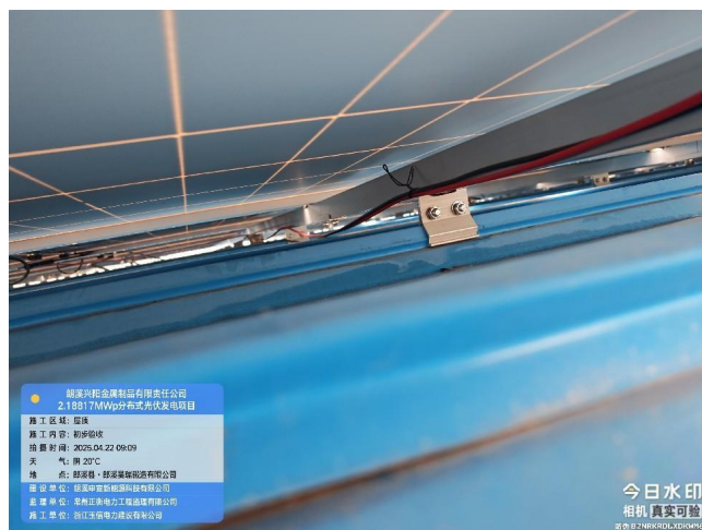
34、现场所有热镀锌材料切口需要做防腐
