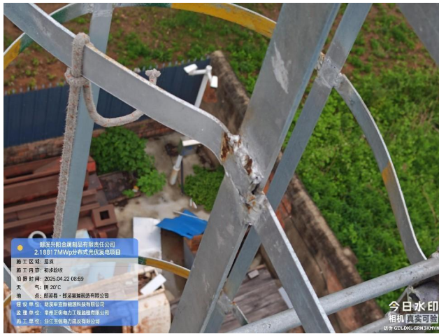
21、逆变器雨棚下角刚需要包边
