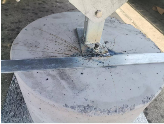
3、接地扁铁未有效接地
