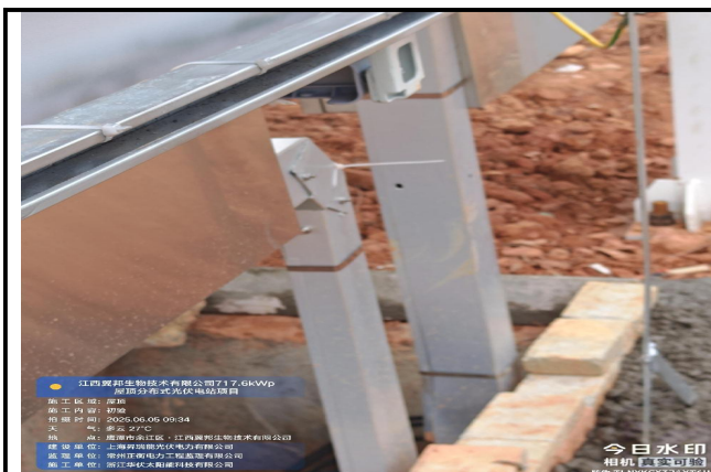
27、接地扁铁搭接面积不符合要求
