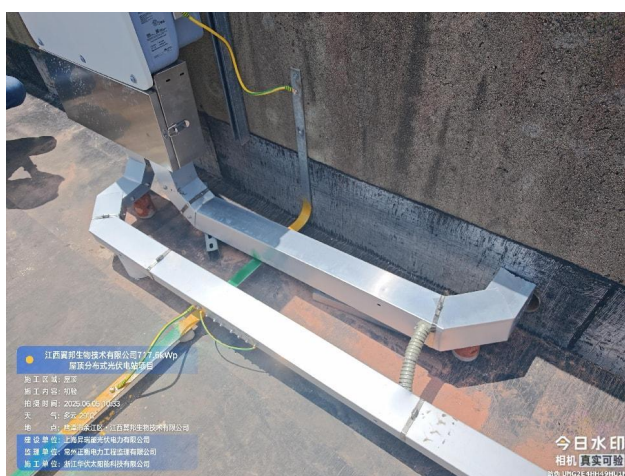
10、组件 MC4 插头使用不锈钢卡扣固定
