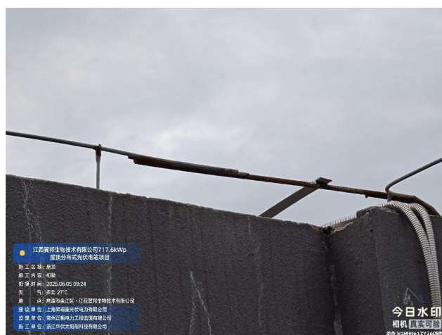
28、直流电缆软管固定均使用不锈钢扎带
