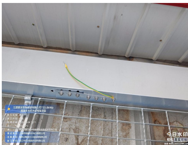
36、桥架接地线缺少螺栓
