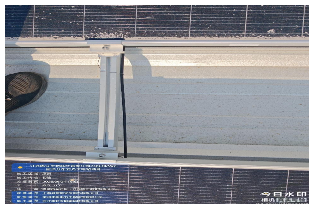
20、使用不锈钢扎带固定
