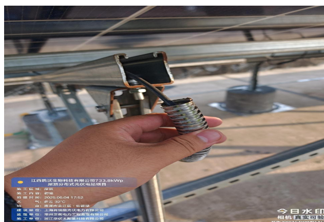
8、组件下方 MC4 插头应使用不锈钢卡口固定
