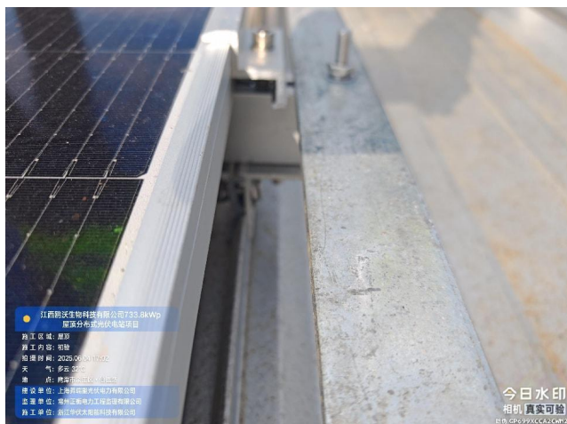
36、桥架接地线缺少螺栓
