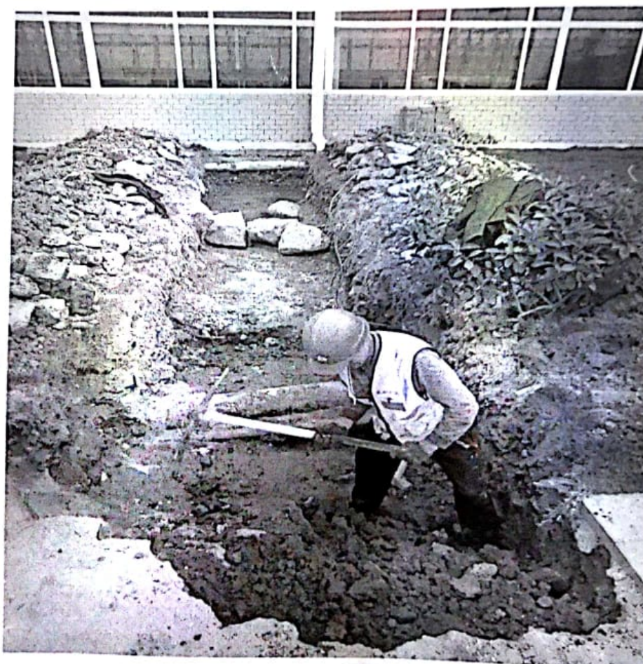
四、电缆管道人工开挖
