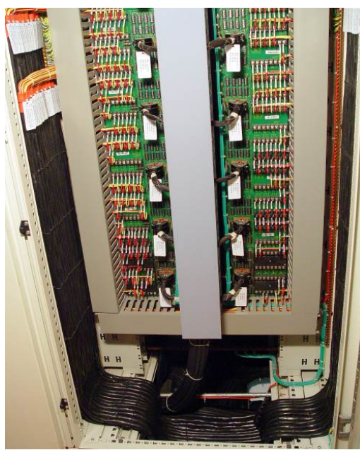
图八柜内接线工艺样板图
