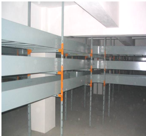
图一 电缆支架桥架安装样板图
