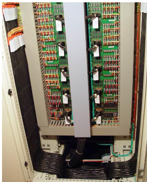
图八柜内接线工艺样板图
