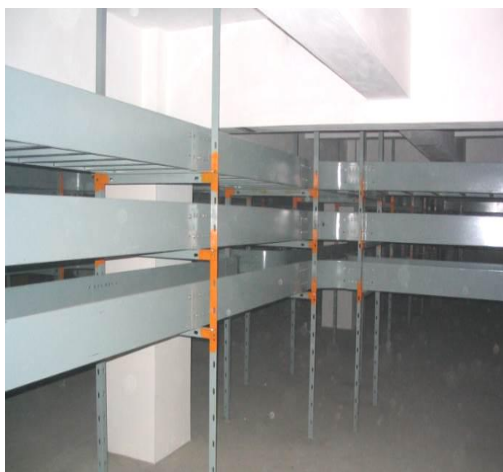
图一 电缆支架桥架安装样板图
